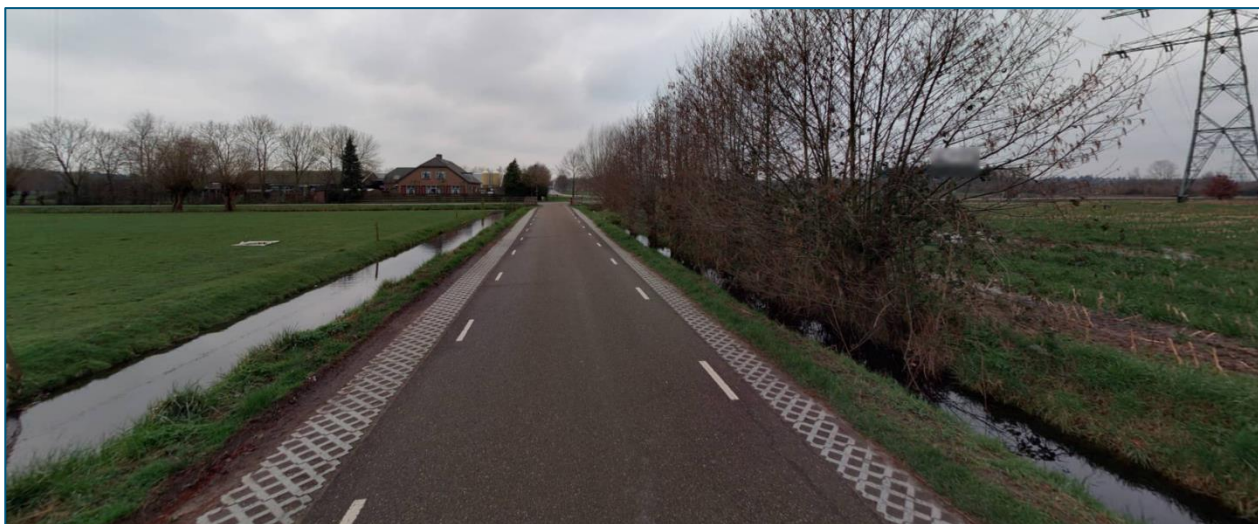
Figuur 3-13 Bermverharding langs de Rottegatsteeg
